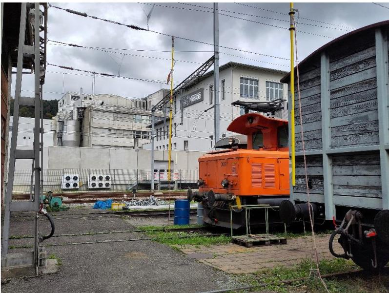
Infolge Lieferschwierigkeiten verzögerten sich die vorschriftsgerechten Umbau- und Anpassungsarbeiten am Ausschaltposten und der fixen Erdung unserer Fahrleitung vor dem Depot. Mit dem Abschliessen des Schaltpostens und 2 von Furrer&Frei zur Verfügung gestellten geprüften Erdungsstangen (Bildmitte) konnte für die Dauer der Dachsanierung ein sicheres Provisorium erstellt werden. Hinter dem Gleis 51 liegt schon das für das Sicherheitsgeländer auf dem Dach bereitliegende Material bereit.
