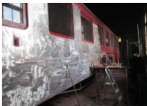
Ein Silberling bei der DBB? Nein, unser Bri 5117 in der Malerei beim Abschleifen der alten Farbe! Zum Glück ist der Wagenkasten aus Aluminium, so kann bis aufs blanke Metall geschliffen werden.
