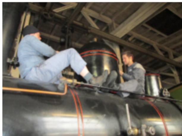
Am Tag nach der Kesselinspektion wird die Dampfdomhaube bei Lok GTB 3 wieder montiert. Ein kniffliges Unterfangen, da das Ganze extrem genau passt...
